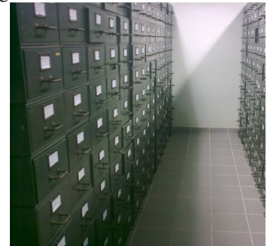
AHU – reinstalação em gavetas
