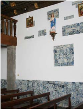
Figura 185 | Revestimento cerâmico na nave da igreja de São Miguel de Mezio. 1750, Basílio do Rego (mestre azulejador). FA.
